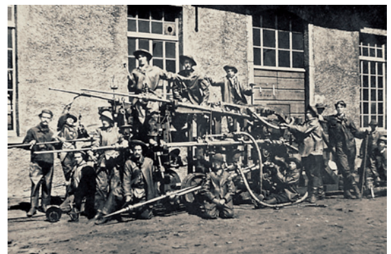
Fig. 2: Perforatrice ad aria compressa utilizzata per lo scavo della galleria ferroviaria del S. Gottardo (1872-1882). In: K. Kovari/R. Fechtig, Trafori alpini storici in Svizzera, Zurigo, 2000, p. 6., Stäubli AG Zürich
